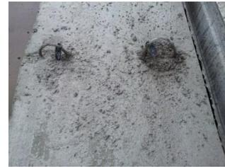
Heben Sie die Platte so an, dass der von beiden Ketten gebildete Winkel kleiner oder gleich  $60^\circ$  ist.
